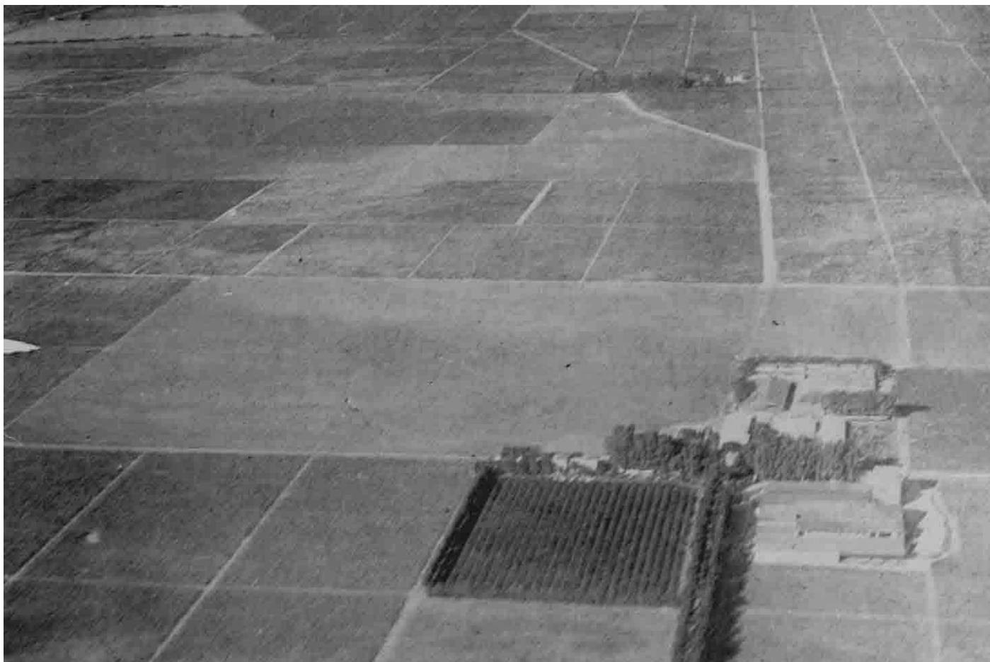
▲ En 1932, la Grande Ferme à Mouzaiaville et la parcelle attenante utilisée comme aéroport
